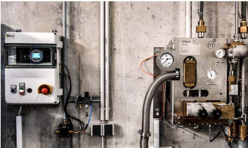
Diese autarke Lösung ist für den Einstieg in die automatische Abfüllung konzipiert. Nach dem Anschluss der Gas- und Stromversorgung ist das System betriebsbereit. Alle Einstellungen werden direkt in einer einfachen Steuerung vorgenommen und können je nach Konfiguration sowohl Einzel- als auch Mehrfachzylinder und Bündel befüllen.
